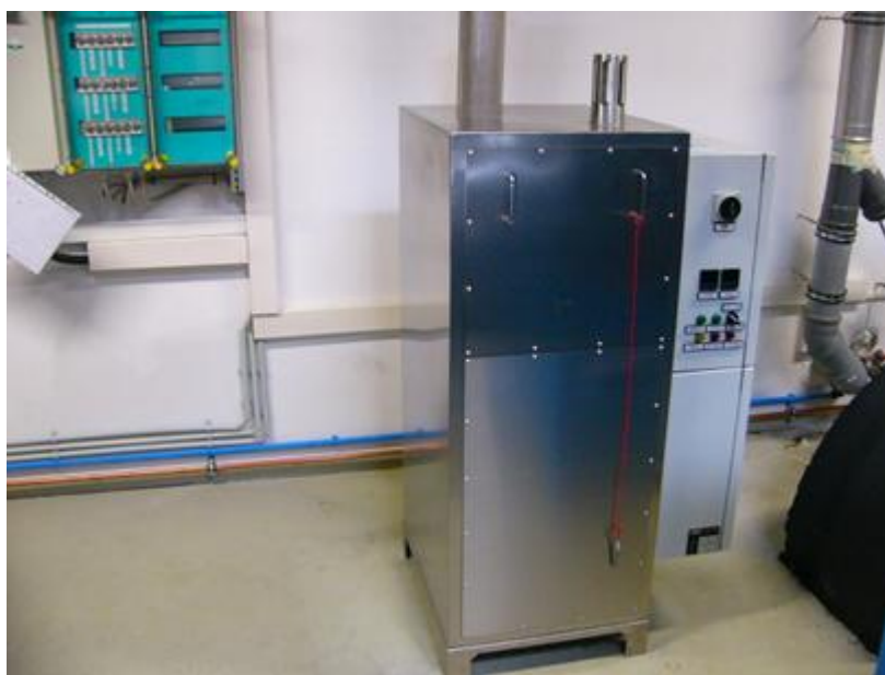
Abbildung 9: TNV-Anlage zur Behandlung der EO-Gasmischung
