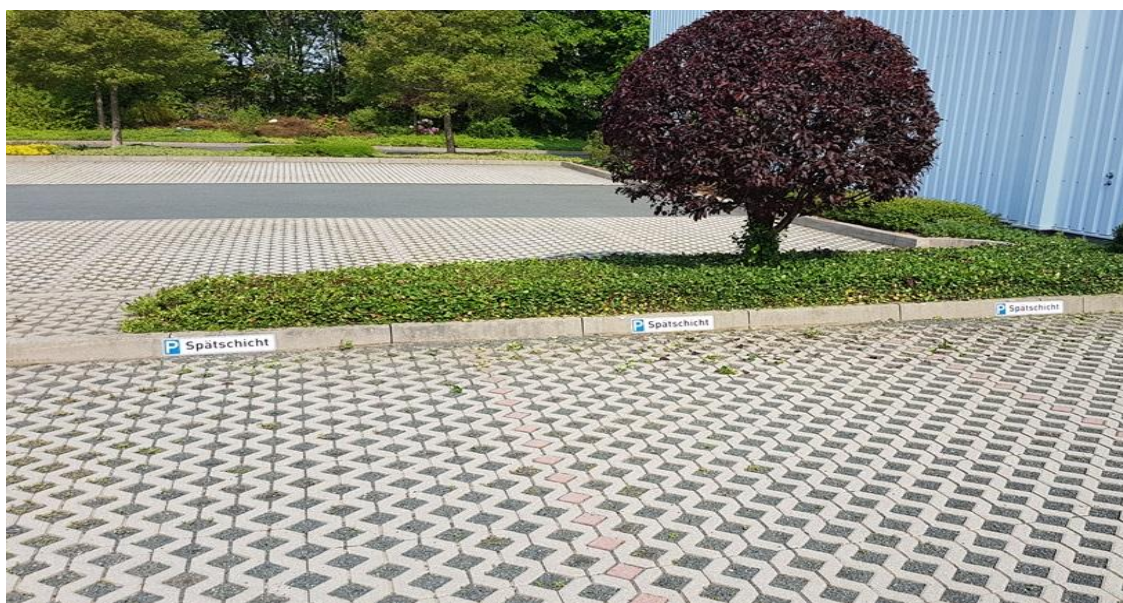
Abbildung 10: Parkplätze mit Gittersteinen ohne Flächenversiegelung
