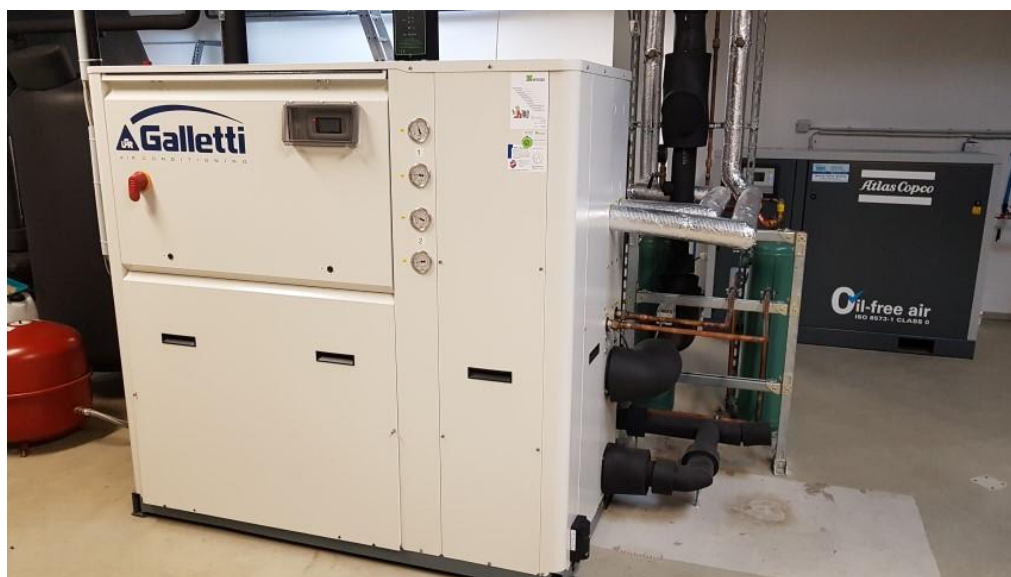
Abbildung 6: Große Kältemaschine (incl. Leckdetektion)
